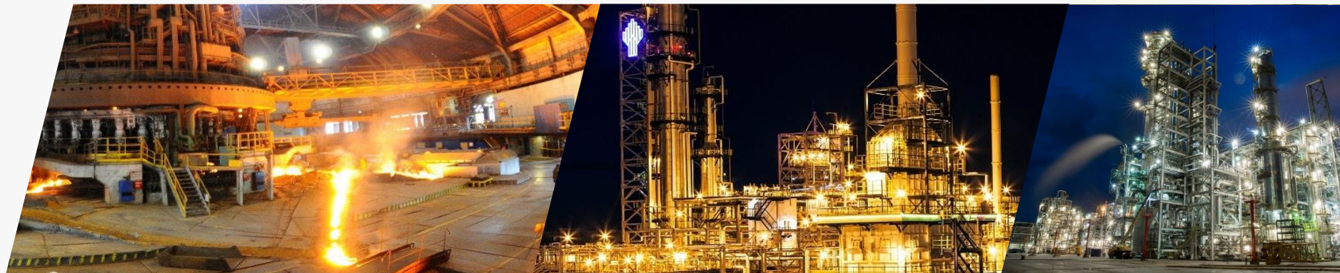
Объекты металлургической, нефтегазовой и химической промышленности
